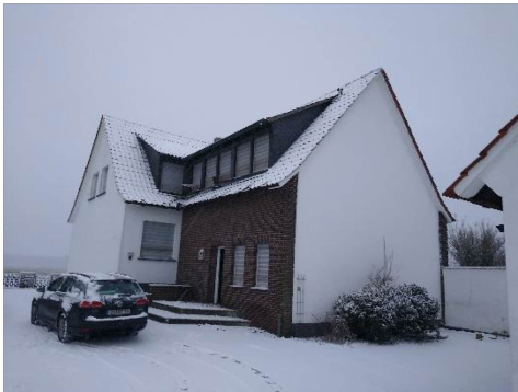
Abbildung 1: Blick nach Süden auf das Wohngebäude
